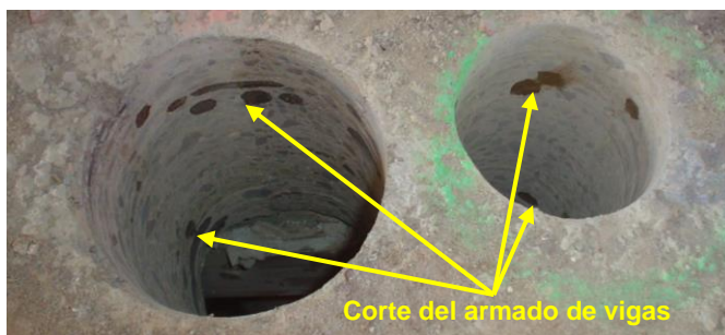
Fig. 11 y 12. Apertura de huecos en elementos estructurales (vigas y viguetas) para paso instalaciones. INCORRECTO.
