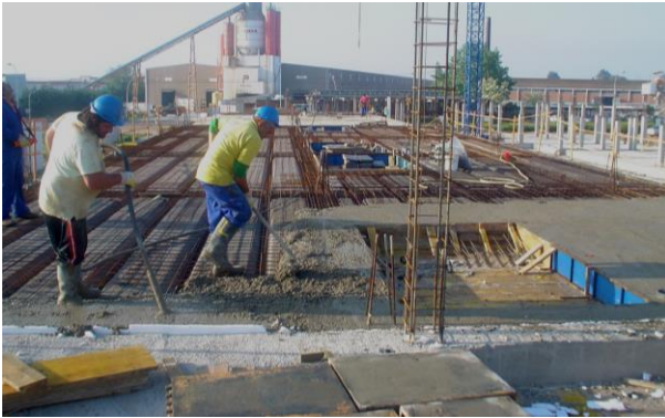
Fig. 35 y 36. Fase de hormigonado de forjado
