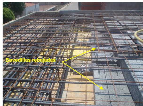
Fig. 8 y 9. Macizados de los extremos de viguetas en zona de apoyos
