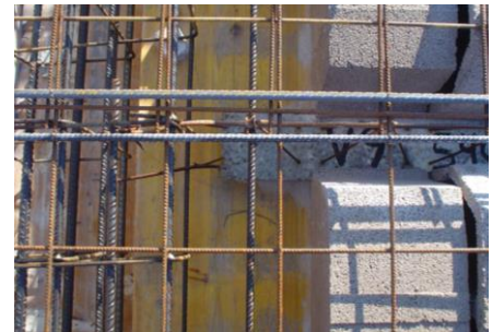
Fig. 15 y 16. Apoyo sobre viga de canto. Enlace por introducción de la armadura saliente
