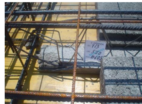
Fig. 25 y 26. Apoyo sobre viga plana. Enlace por introducción de la armadura saliente
