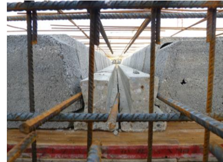
Fig. 21 y 22. Apoyo sobre muro de carga. Enlace por introducción de la armadura saliente
