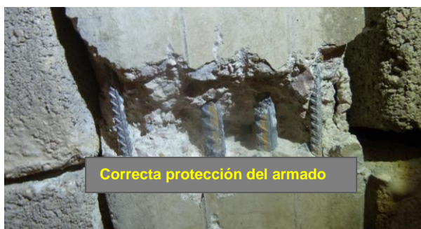
Fig. 32 y 33. Comportamiento de los recubrimientos del armado de viguetas, según espesores y/o calidad del hormigón
