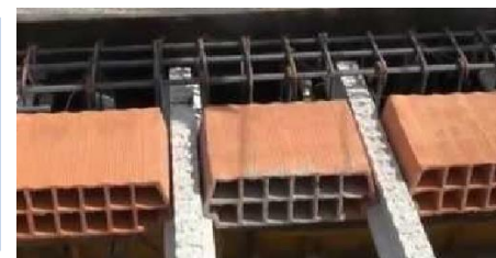
Fig. 27 y 28. Apoyo sobre viga plana. Enlace por entrega
