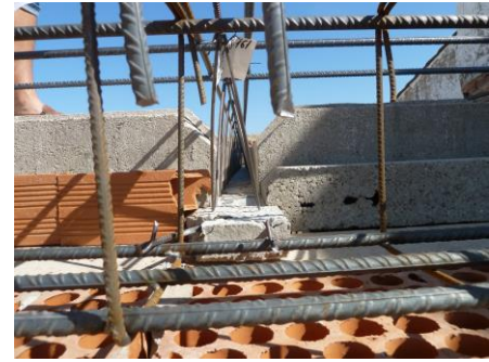
Fig. 21 y 22. Apoyo sobre muro de carga. Enlace por introducción de la armadura saliente
