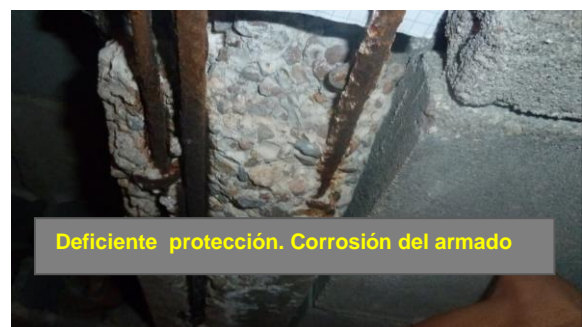
Fig. 32 y 33. Comportamiento de los recubrimientos del armado de viguetas, según espesores y/o calidad del hormigón
