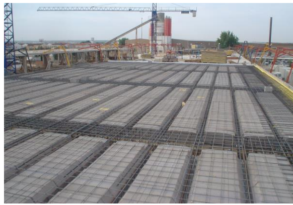
Fig. 1: Vista general forjado unidireccional
