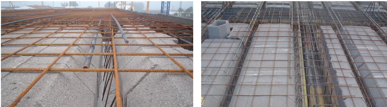
Fig. 29 y 30. Colocación armado de negativos y mallazo de reparto
