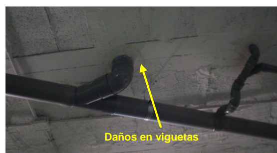
Fig. 11 y 12. Apertura de huecos en elementos estructurales (vigas y viguetas) para paso instalaciones. INCORRECTO.
