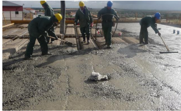
Fig. 35 y 36. Fase de hormigonado de forjado
