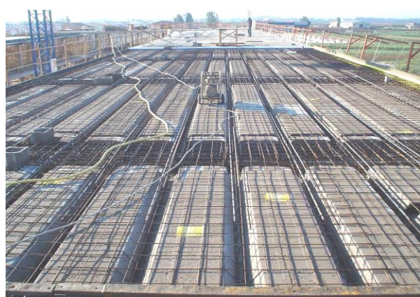
Fig. 1: Vista general forjado unidireccional
