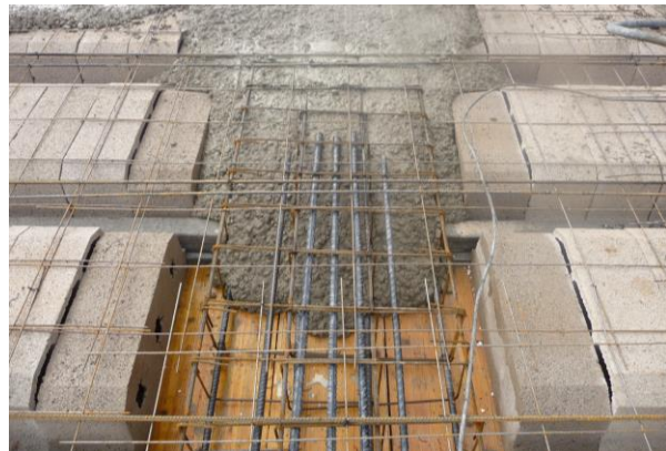
Fig. 2: Hormigonado forjado unidireccional
