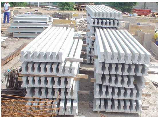
Fig. 4. Acopio de viguetas sin identificación
